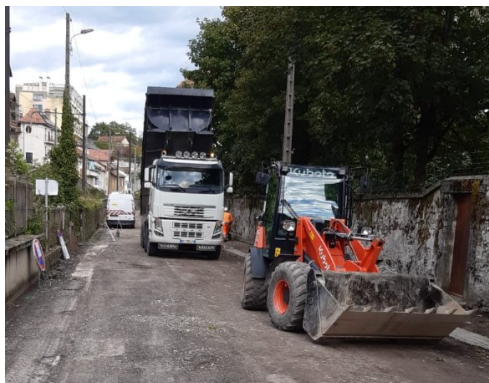
Goudronnage du Boulevard Bonivard
